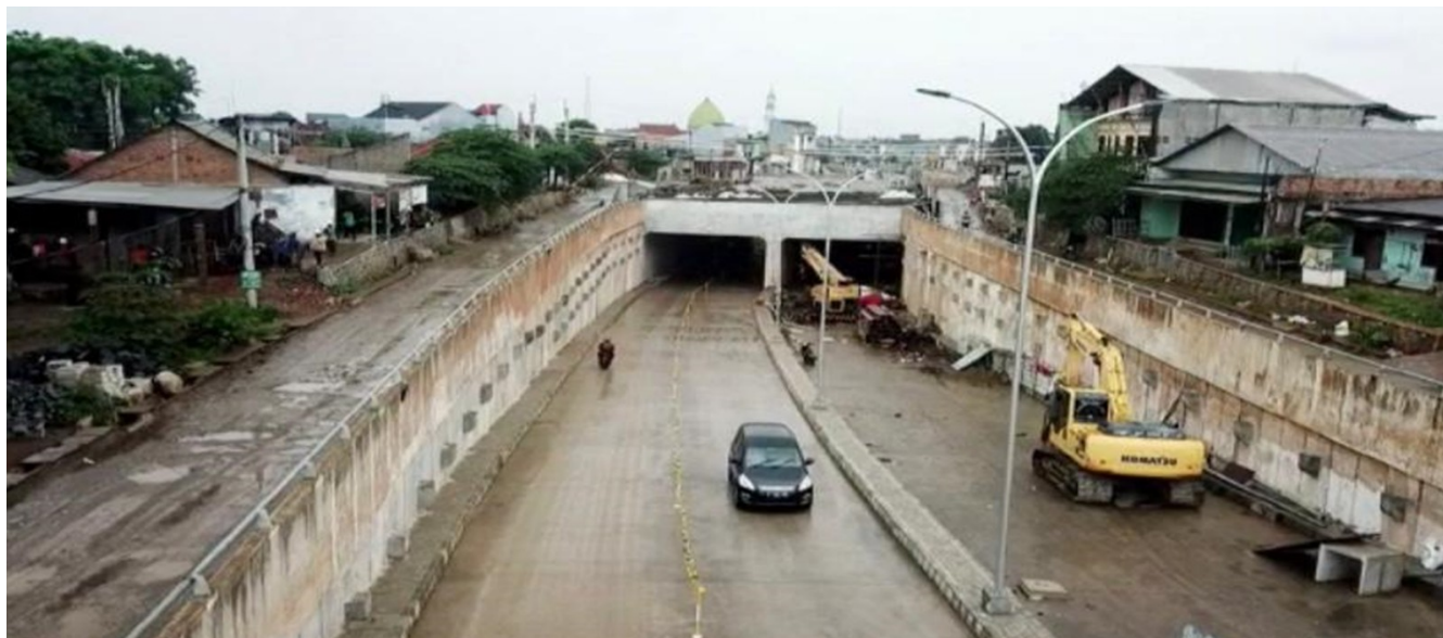
UNDERPASS - PRECAST DIAPHRAGM WALL SETELAH DIGALI
