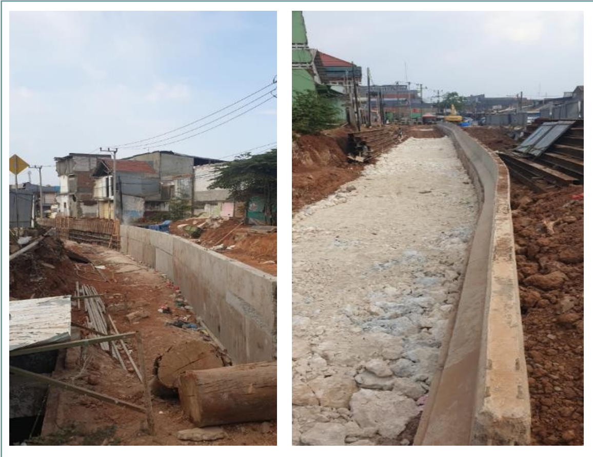
5. Pembuatan Caping beam
