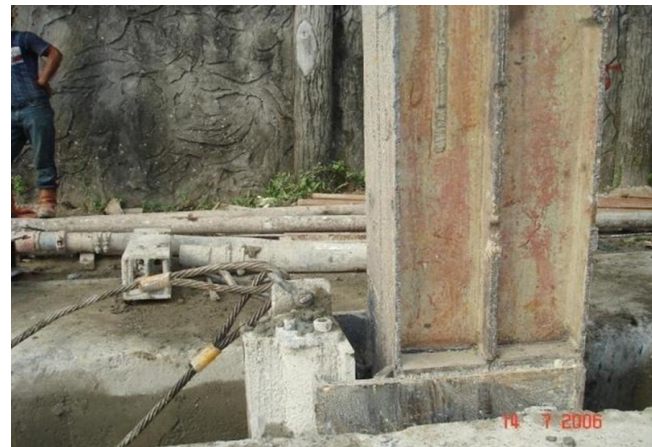
Pelepasan CWS joint dengan Chiselling
