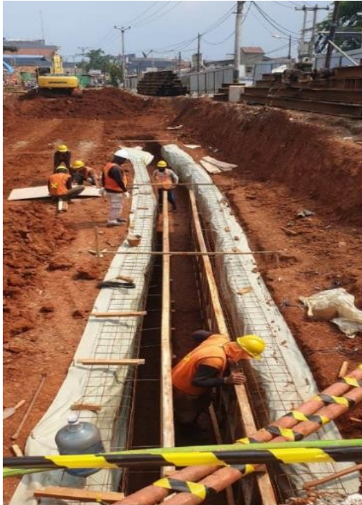
1. Pembuatan Guide Wall
