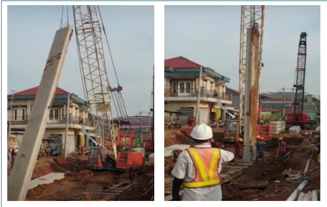
3. Pengangkatan dan Pemasangan panel DW
